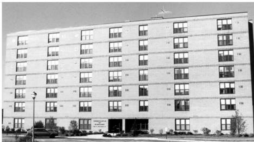
Рис. 1.1.2. Семиэтажный дом в Green Castle (Elmhurst, IL), США с неущими наружными стенами с лицевым слоем из кирпичной кладки на гибких связях и внутренним слоем из бетонных /1.2/.
