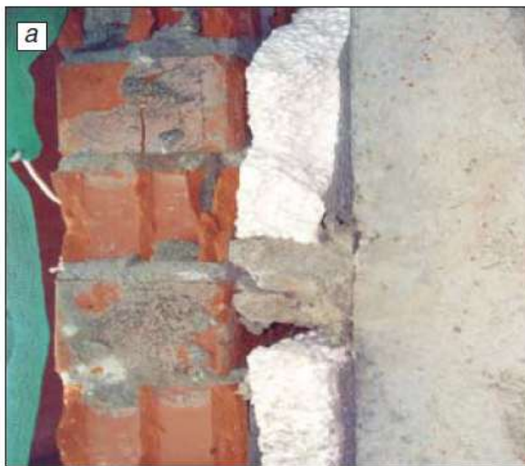
Рис.2.2.1а,б. Пример некачественной укладки плитного утеплителя из пенополистирола в наружной стене г. Красногорск. 1999 г: а- в месте примыкания наружного слоя к железобетонной колонне; б- в трехслойной кладке.
