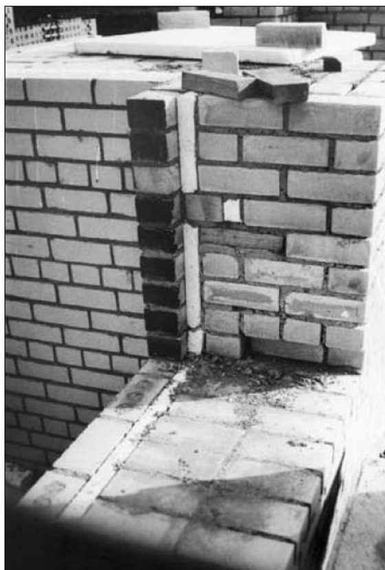
Рис.1.2.26. Возведение первого в России жилого дома высотой 12 этажей с наружными несущими стенами с кладкой с уширенным швом, заполненным эффективным (плиты из пенополистерола) утеплителем, г. Апатиты. Технические решения 1990 г.
