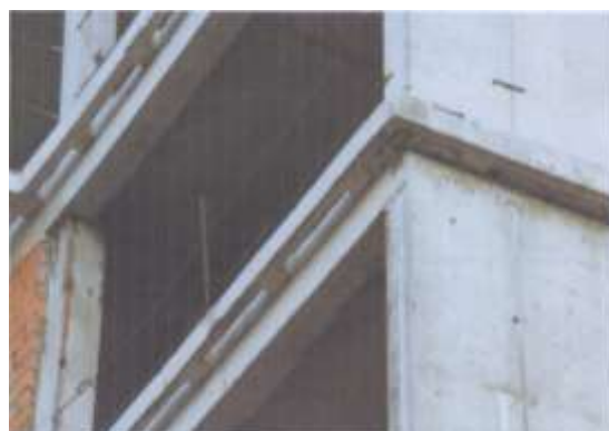
Рис. 1.2.29 а, б, в. Возведение жилого дома с наружными несущими стенами из облегченной кладки, устанавливаемыми на перекрытие. Москва, Рублевское шоссе, 1999 г. а- общий вид; б- балконная плита с отверстиями под утеплитель; в- железобетонные консоли с отверстиями под утеплитель для установки наружного слоя кладки
