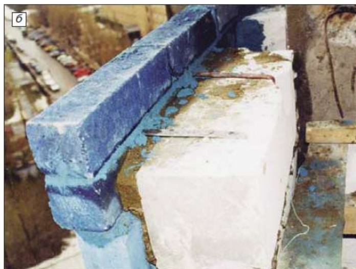
Рис.2.5.3. Стена с лицевым слоем толщиной 9 см из бетонного кирпича, крепящегося к внутреннему слою связями из стальной полосы без антикоррозионного покрытия, Москва, 2002 г.
