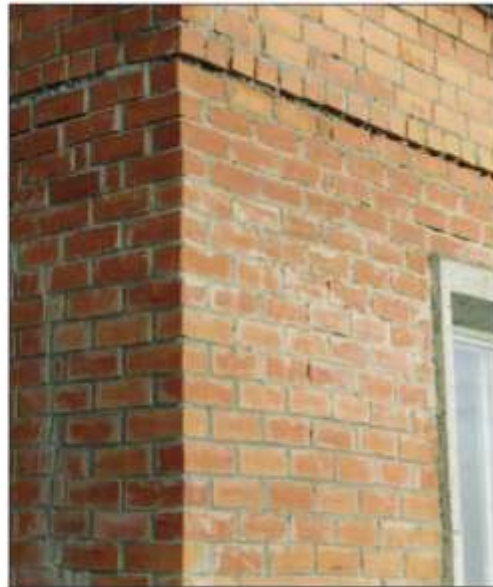
Рис. 2.3.4 Заполнение горизонтального деформационного шва кладочным раствором. Москва, 1999 г.
