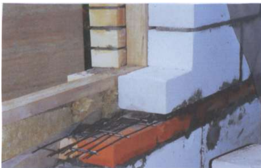
Рис. 1.2.28. Жилой шестиэтажный дом с наружными стенами из трехслойной облегченной кладки, устанавливаемыми на перекрытия; ул. Молодогвардейская, Москва, 1999 г. а- общий вид; б- фрагменты наружной стены
