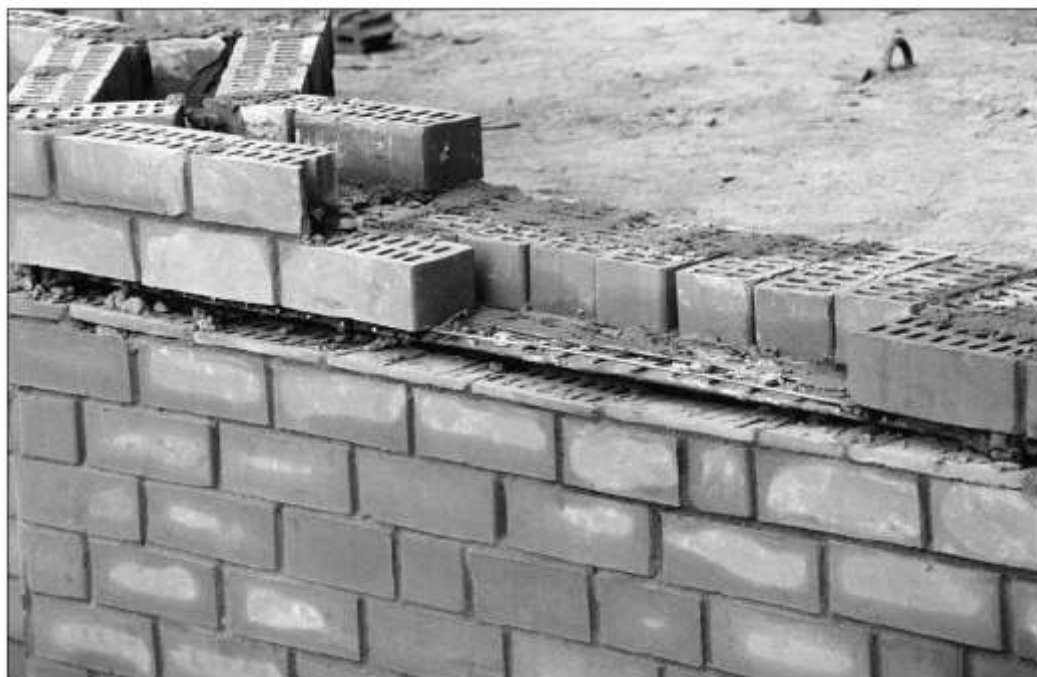
Рис. 1.2.30. Строительство 22-этажного жилого дома с наружными стенами из колодезной кладки. Опираение внутреннего слоя стены производится на перекрытие, наружного слоя – на стальной уголок, ул. Молодогвардейская, Москва, 1999 г.
