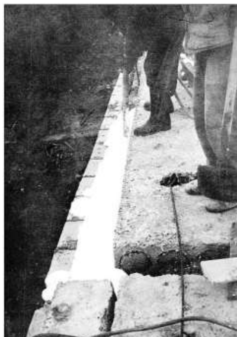
Рис.1.2.18. Заливка утеплителем МФП-2 облегченной кирпичной наружной стены пятиэтажного жилого дома в Электростали. 1973
