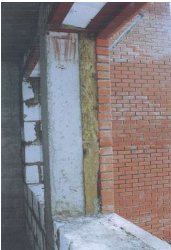
Рис. 1.2.27г. Установка эффективного утеплителя между лицевым слоем и железобетонной колонной
