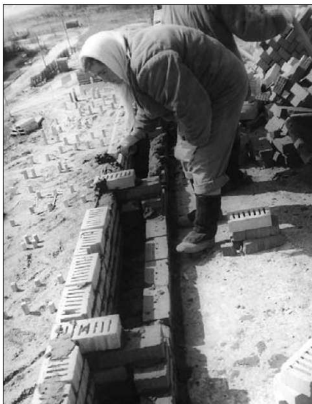
Рис. 1.2.25. Возведение первого в России девятиэтажного жилого дома с наружными самонесущими стенами из облегченной кладки с вертикальными диафрагмами в г. Воскресенске Московской области. Технические решения. 1991 г.
