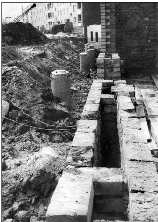
Рис.1.2.15. Облегченная кладка наружной стены пятиэтажного жилого дома серии 85 (Волоколамское СМУ треста Мособлстрой-18). 1978 г.
