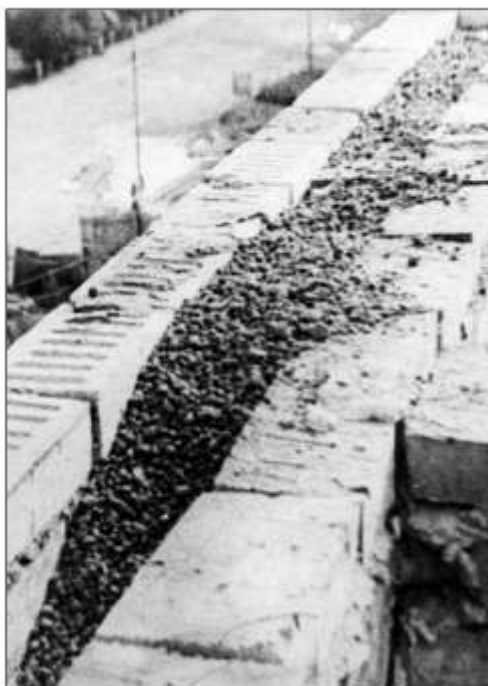
Рис.1.2.17. Строительство пятиэтажного жилого дома серии 85 в Волоколамске. Облегченная кладка кирпичных стен, утепленных керамзитовым гравием (Волоколамское СМУ треста Мособлстрой-18). 1978
