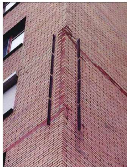
Рис.2.3.13. Усиление кладки в местах образования вертикальных трещин. Несвижский переулок, Москва. 2002г.
