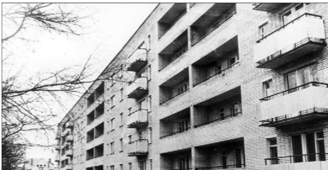
Рис. 1.2.14 Общий вид пятиэтажного жилого дома с наружными стенами из кладки. Электросталь. 1973 г.
