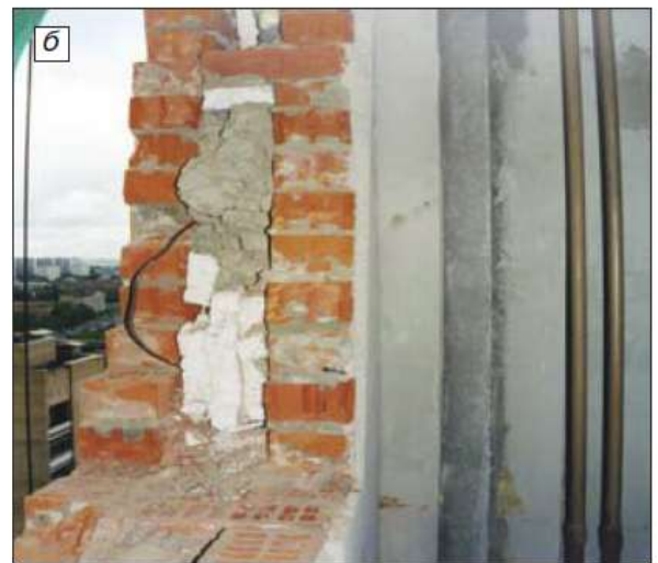
Рис.2.2.1а,б. Пример некачественной укладки плитного утеплителя из пенополистирола в наружной стене г. Красногорск. 1999 г: а- в месте примыкания наружного слоя к железобетонной колонне; б- в трехслойной кладке.
