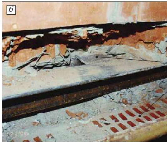
Рис. 2.3.4 Заполнение горизонтального деформационного шва кладочным раствором. Москва, 1999 г.
