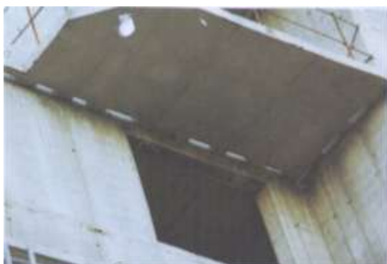
Рис. 1.2.29 а, б, в. Возведение жилого дома с наружными несущими стенами из облегченной кладки, устанавливаемыми на перекрытие. Москва, Рублевское шоссе, 1999 г. а- общий вид; б- балконная плита с отверстиями под утеплитель; в- железобетонные консоли с отверстиями под утеплитель для установки наружного слоя кладки
