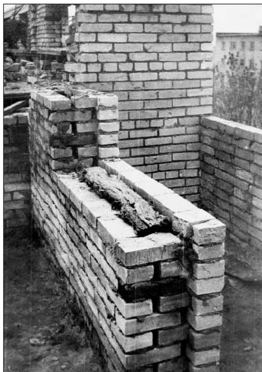
Рис.1.2.16. Наружная стена, утепленная минераловатной плитой, пятиэтажного жилого дома в Электростали. 1973 г.
