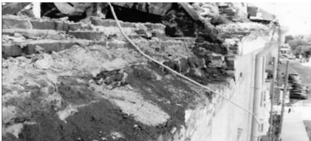
Рис. 1.2.12. Кладка наружных стен с внутренним слоем из шлакобетонных камней. Музыкальный театр им. К.С.Станиславского и В.И. Немировича-Данченко, 1930-е гг. Фото 2005 г.
